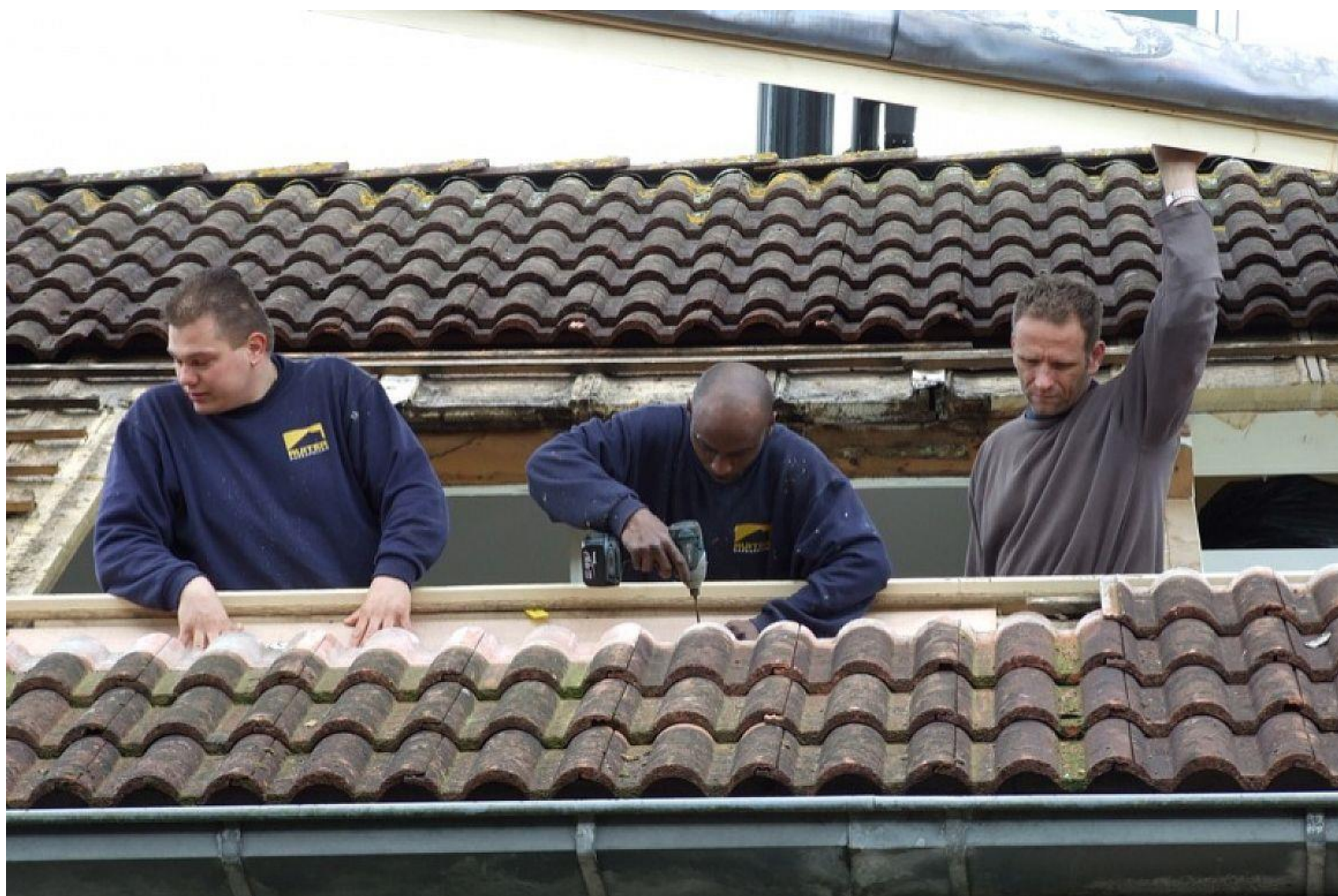
Bouwvakkers dekken de dakisolatie af Gert Jan Kole via Flickr CC
